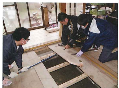
家屋の床下調査の様子
