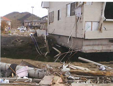
石巻市内液状化の様子
